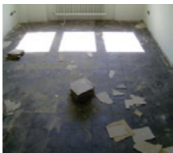
Plošče vinaz, linoleji z azbestnimi vlakni
